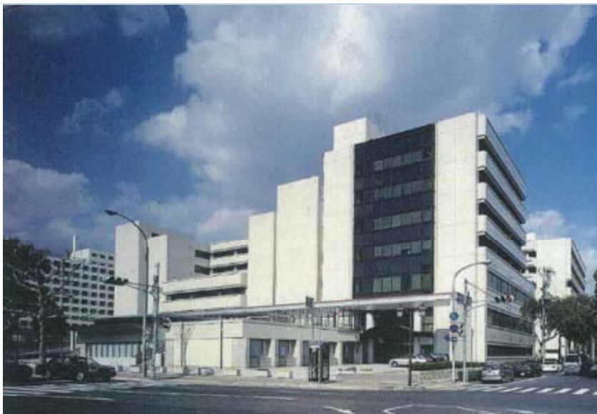
神緑会館(手前平屋建て)と事務棟・附属病院外来棟全景(左奥に旧第一病棟を望む) 平成13年11月
