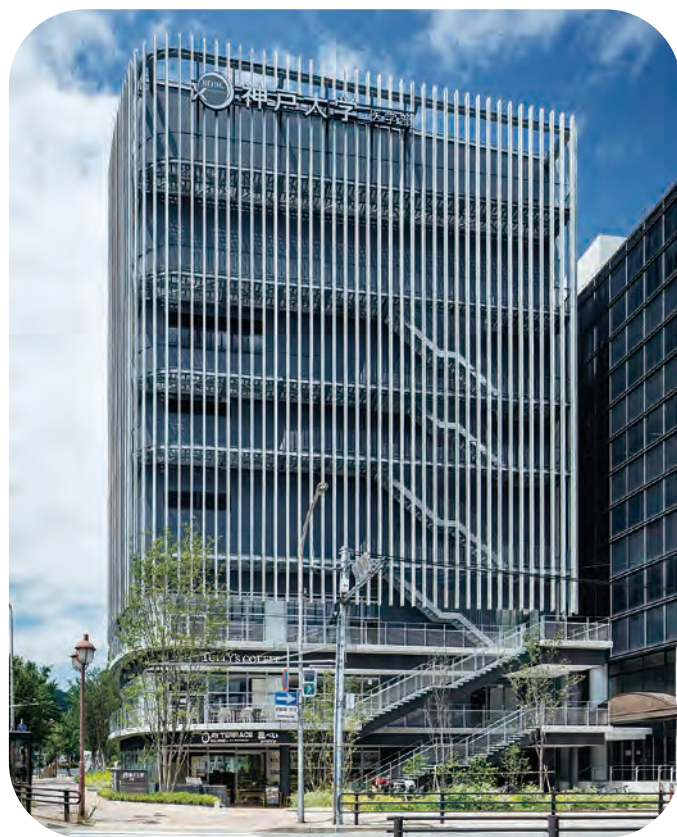
「福利厚生施設・写真撮影」 長谷川 健太
