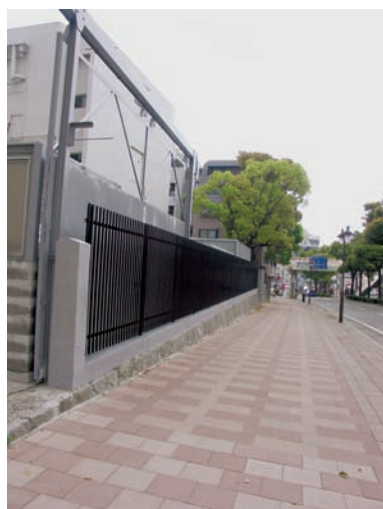
改修された外壁
