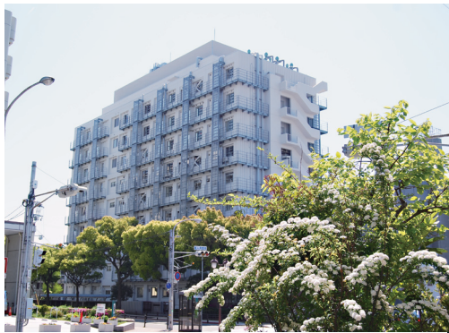
研究棟B全面改修後 (旧基礎北棟)
