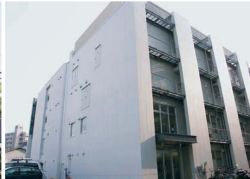
共同研究館・寄付建物 (保育所プレハブ撤去後)
