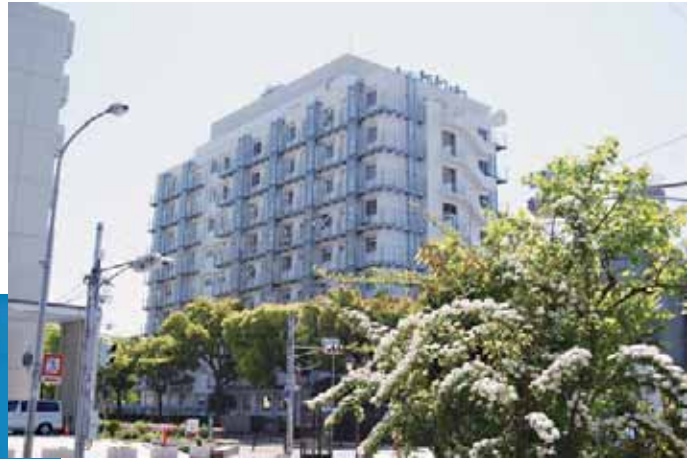
研究棟 B 全面改修後（旧基礎北棟）
