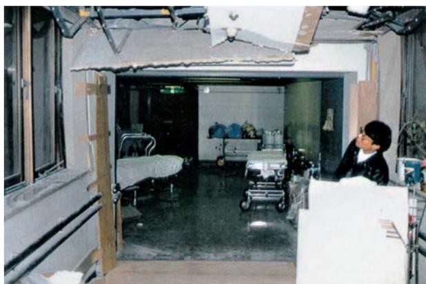
写真2 中央診療棟と第一病棟のエキスパンション部分の損壊
