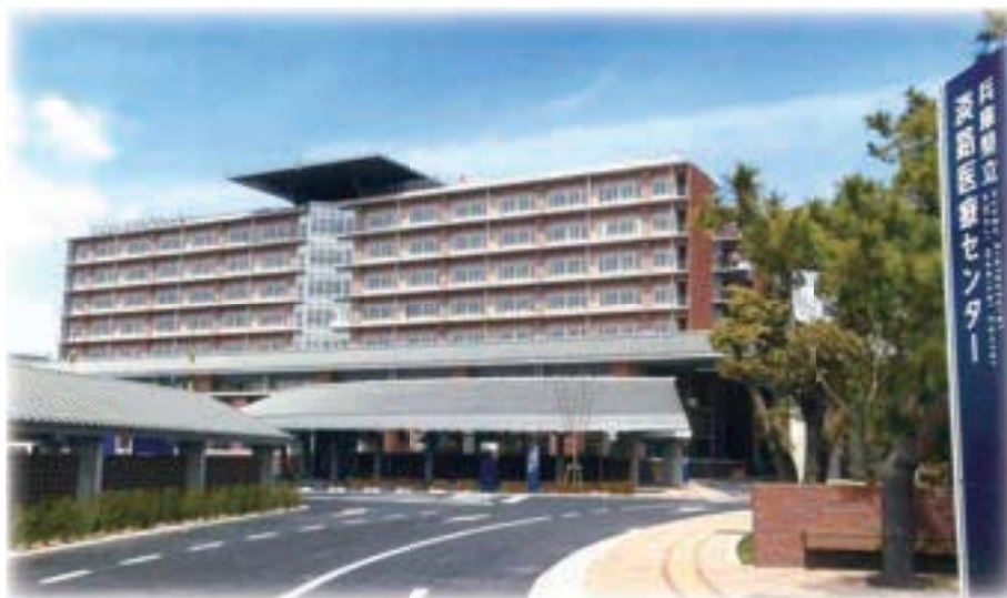
兵庫県立淡路医療センター
