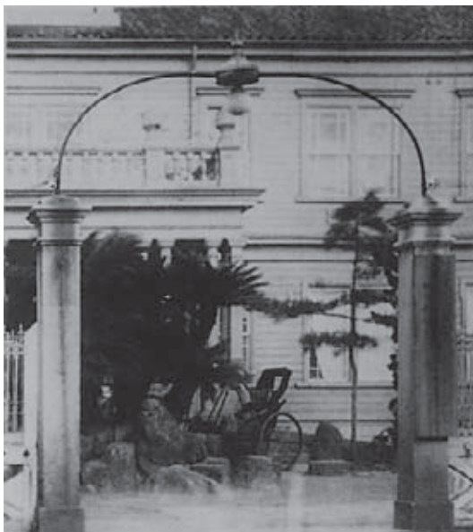
写真1 明治33年の神戸病院の正門
