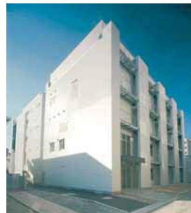
耐震改修した旧共同研究館
